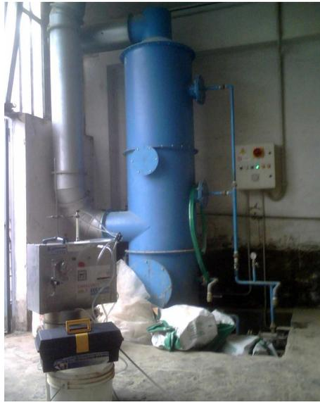
Controllo corretto funzionamento impianti di abbattimento Scrubbers. (Ad acqua, soda, acido. ) per abbattimento vapori.
